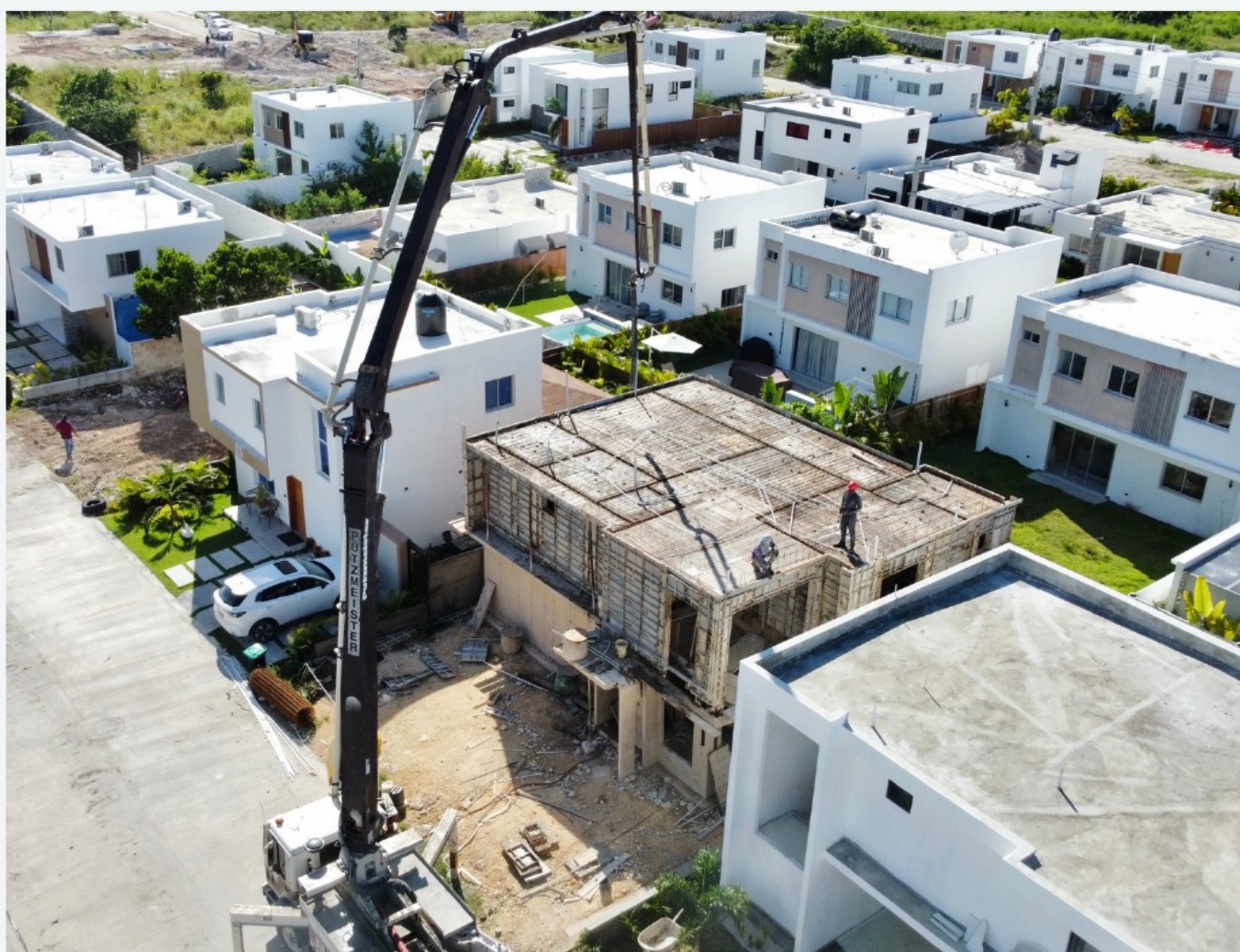
Preparación para el vaciado de losa
