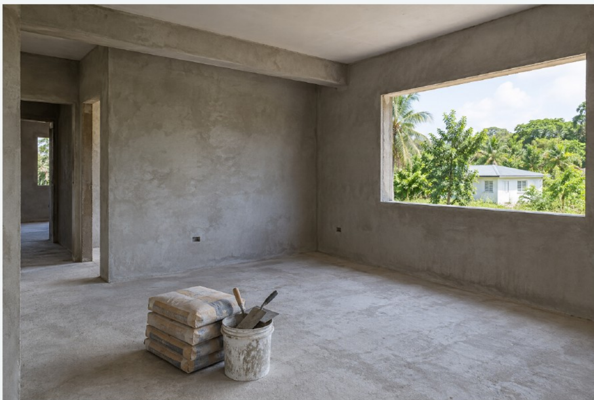
Preparación de superficies y terminaciones
